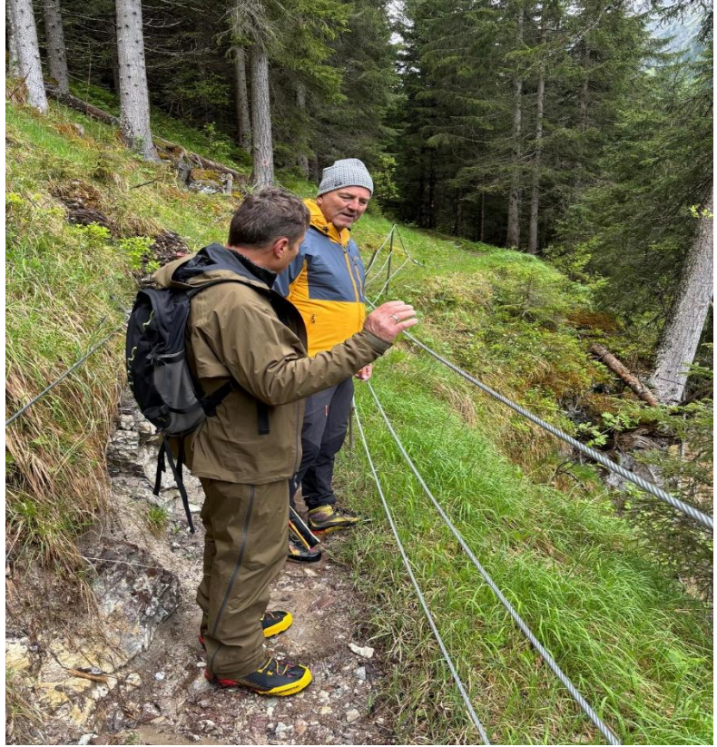
Diese Stelle wurde sowohl bergseitig mit einem Drahtseil versichert als auch talseitig sichtbar abgesichert. (15 Meter freier Fall)
