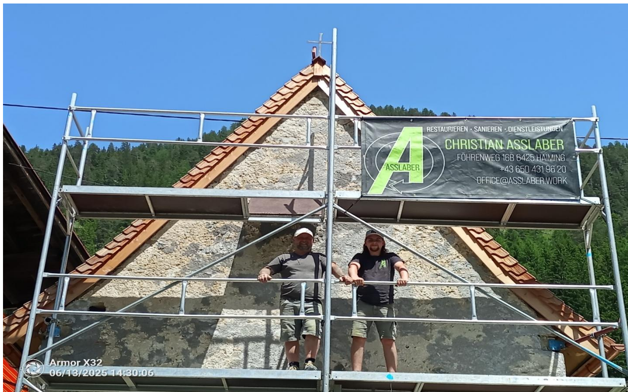
Das Mauerwerk durfte nur vorsichtig mit Kalkputz versehen werden. Der alte „look“ sollte unbedingt erhalten bleiben!
